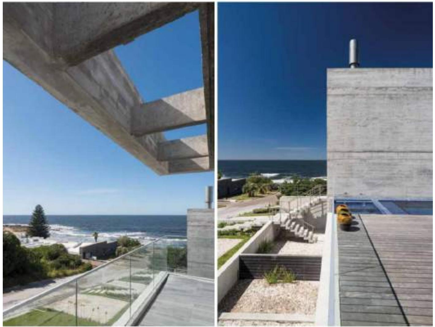
La construcción fue íntegramente realizada en hormigón armado visto, con los encofrados hechos con tablas cortesadas de pino nacional. Los decks son de lapacho natural pulido por el aire marino, el sol y la lluvia. La piletas se resistió en venecitas color cobalto.
